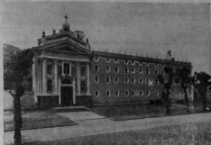
La linea indica il primitivo muro maestro. La crocetta presso la VII finestra del primo piano sul pianterreno indica la finestra di fronte alla stanza ab- itata da S. Alfonso sino al 1767.
