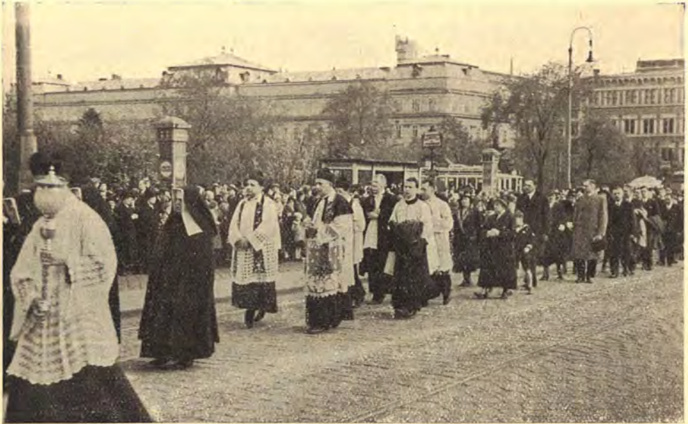
FIG. 2. — Eadem pompa in eadem via, vulgo Kärntnerstrasse .
