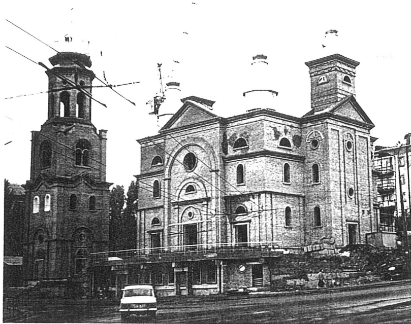
Campanile, chiesa e monastero, in costruzione, a Ternopil
